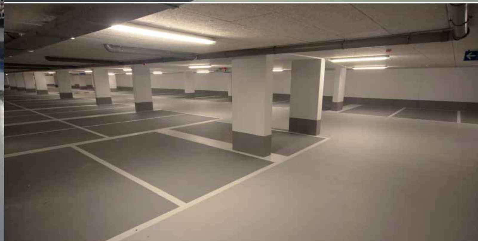
Foto boven: Parkeergarage Brabantplein Uden - onder: Parkeergarage Vughtse Hart Vught
