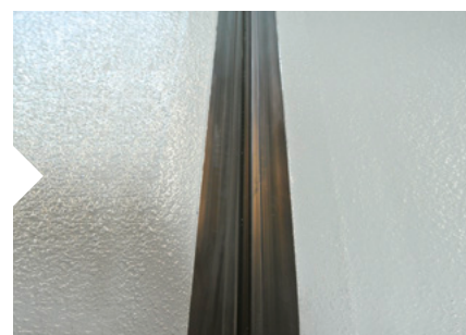
Eindresultaat met coating systeem
