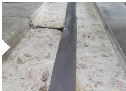
Herprofilering van de (dilatatie) voeg, schuren van de oneffenheden
