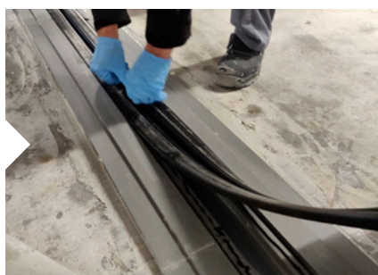
Aanbrengen van verwisselbaar rubber profiel
