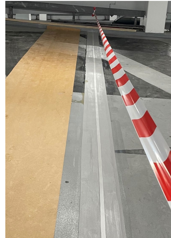
Herstel diletatie profiel
